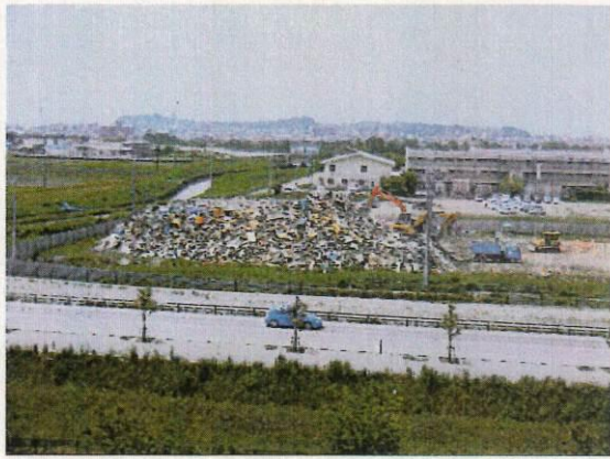
被災現場より搬入された災害がれき
