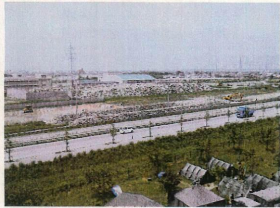
1次仮置き場全体写真
